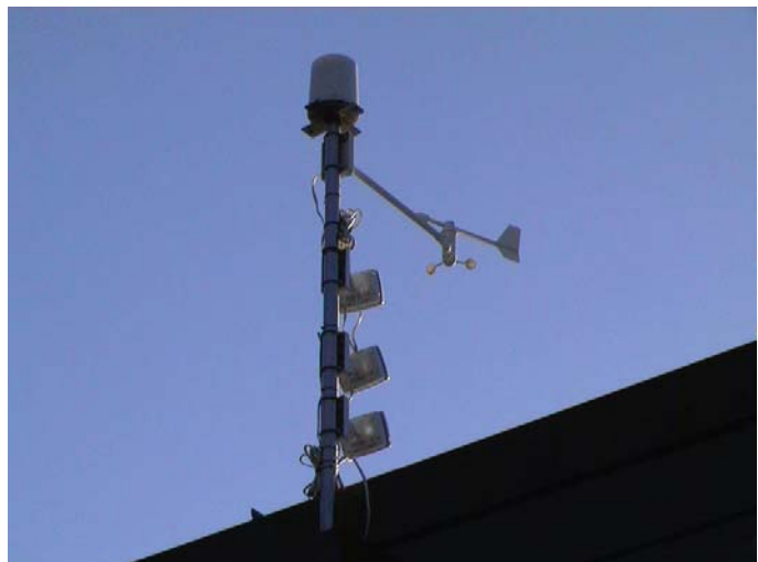
Figur 2: Måleinstrumentene montert på en stang på taket
