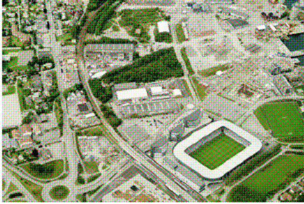
Fig 13: Bildet viser Jåttå stasjon, adkomst fra sørvest, Viking Stadion, næringsbygg med mer.
