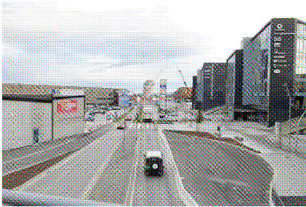
Fig 14: Scenerommet med Skråtårnet som fondmotiv. Senterområde med Viking stadion, shoppingssenter og kontorbygg til høyre. Nybygg for Aker Solutions planlagt på motsatt side av Scenerommet.
